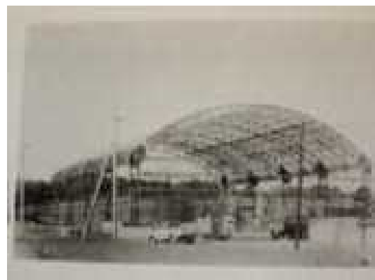
体育館建設の様子 昭和47年
